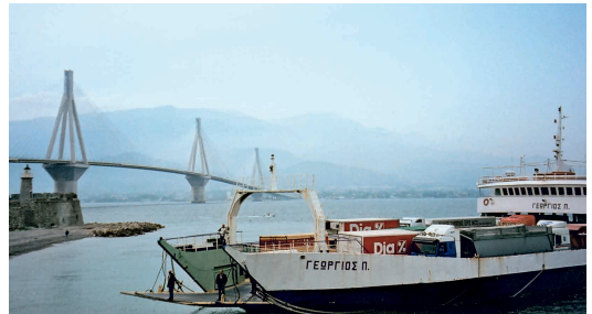
Die 2253 m lange Kabelbrücke im Golf von Korinth.
